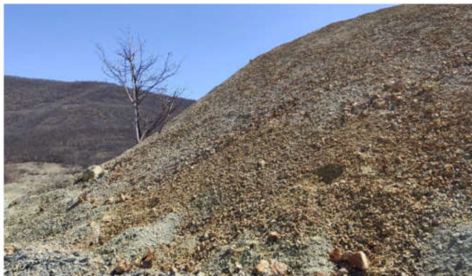
Slika 11.12. Kosina jugoistočnog odlagališta
